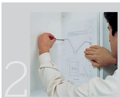
2 Marquer avec un poinçon sur les marques du gabarit. Il y a plusieurs possibilités selon l'angle voulu pour l'égouttoir. Répéter l'opération de l'autre côté.
