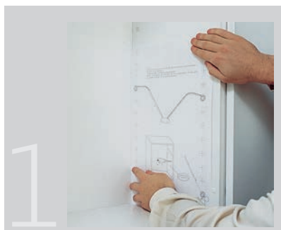
1 Placer le gabarit, en l'appuyant sur la base et au fond du meuble.
